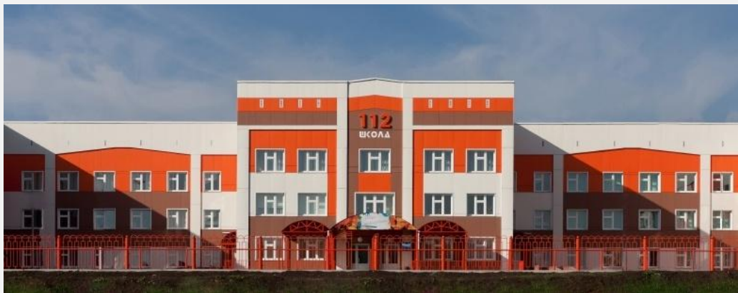
→ Школа №112 Новокузнецк, пр. Мира, 46 Площадь фасада: 9000 кв.м
